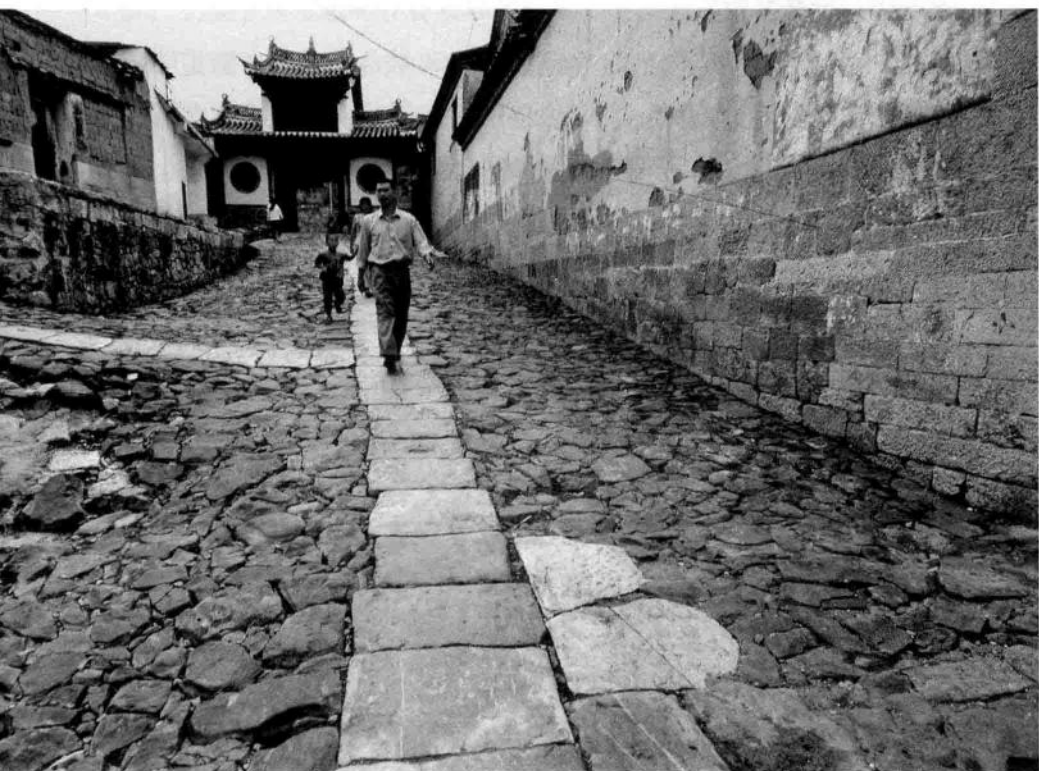
东寨门前的古道
