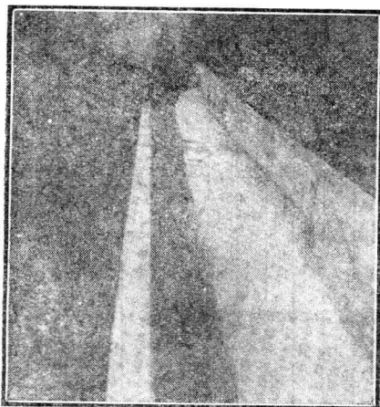
圖 2. 帽溪陡槽, 當 Q=395 立方呎/秒, 自 1+25 站向上游觀察的情況
