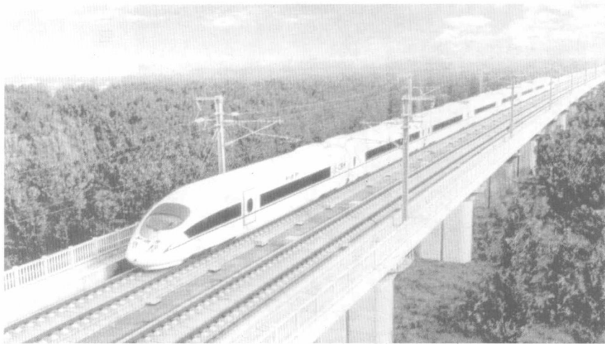
图 1-4 时速 350km 的京津城际铁路
