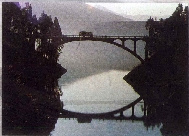
渡人桥 昆畹公路跨北庙 水库，钢筋混凝土 悬半波双曲拱桥
