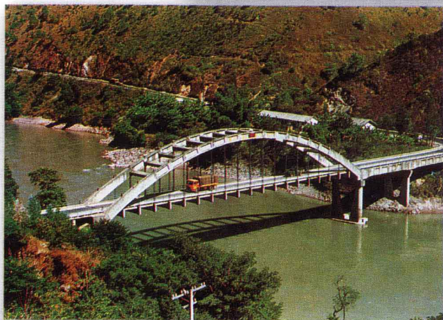
永保桥 昆畹公路跨澜沧江，钢筋混凝土 无系杆下承式肋 拱桥
