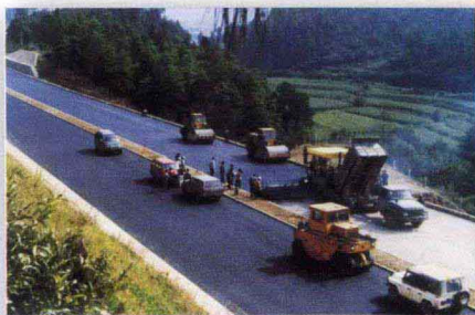
沥青路面机械化施工
