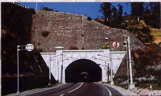
安楚公路上的 孔家庄隧道， 长 260 米
