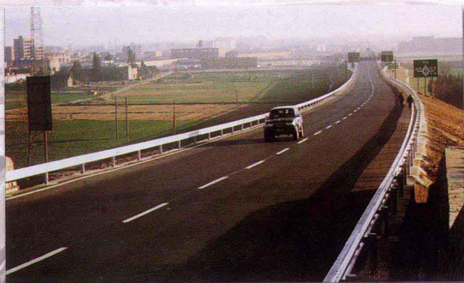
昆明—曲靖间的半幅高速公路
