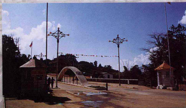
畹町一九谷界河桥，位于中缅边界，跨畹町河，预应力钢筋混凝土下承式单肋柔拱刚性梁桥
