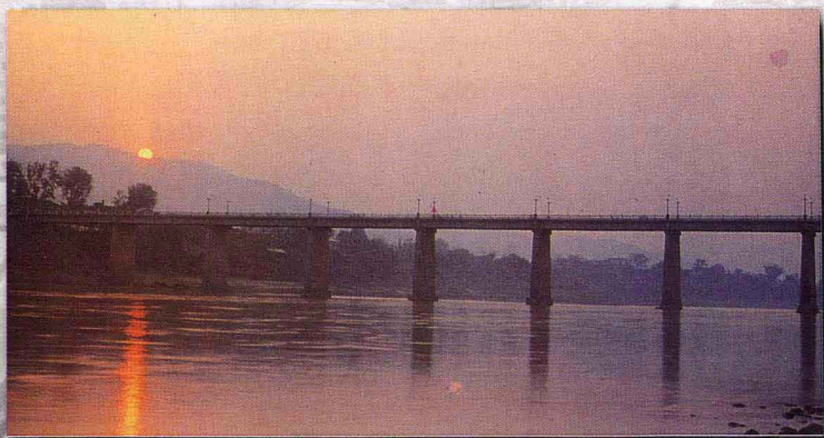
景洪桥 昆洛公路跨澜沧江，钢筋混凝土T型梁桥
