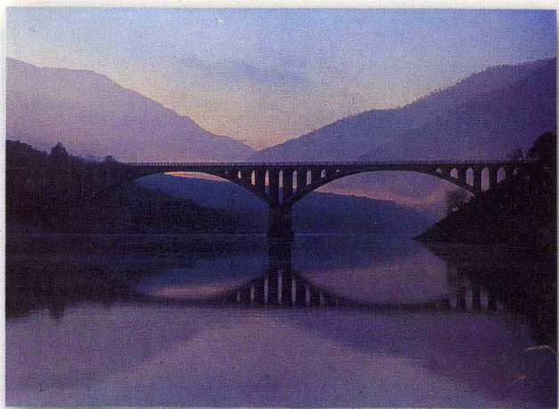
继红桥 滇藏公路跨金沙江， 装配式钢筋混凝土 薄壁箱型拱桥
