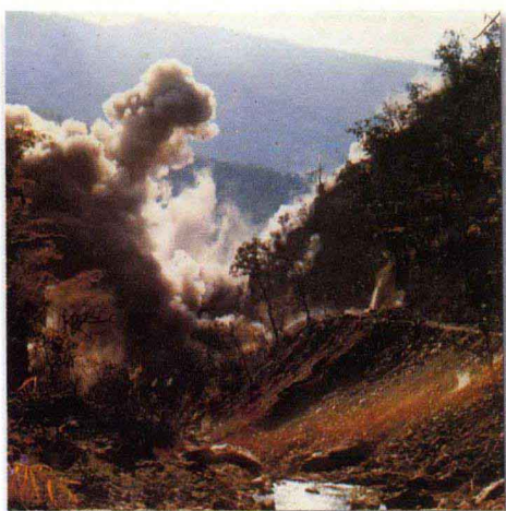
公路路基开挖大爆破施工
