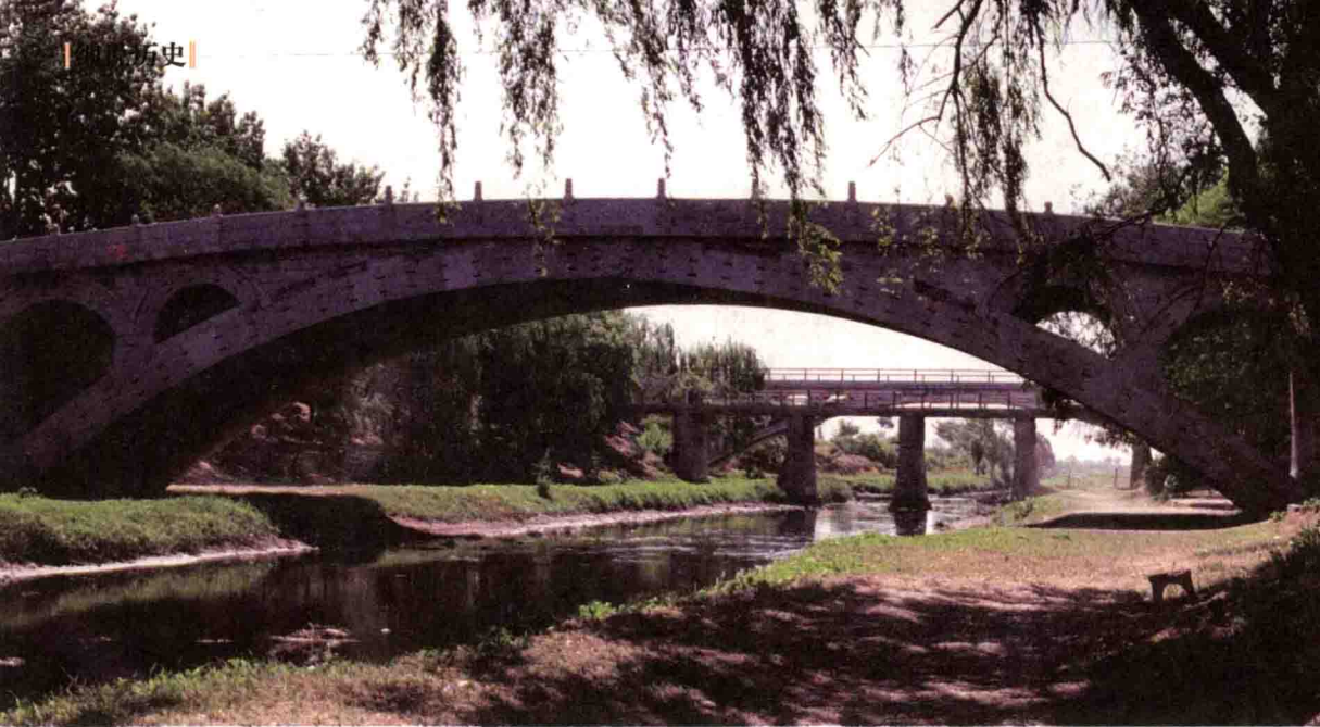
▲ 河北赵州桥，又名安济桥。建于隋朝，由著名匠师李春监造。在赵州桥大拱两肩，砌有4个并列小孔，既增大流水通道、减轻桥身重量、节省石料，又增强了桥身稳定性，使赵州桥在1400年的历史中挺立至今。
