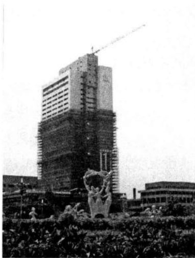
1987年,建造中的杭州大厦初露端倪。
