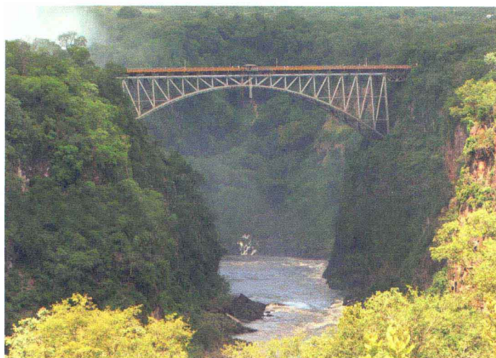
连接赞比亚和津巴布韦的铁路桥
