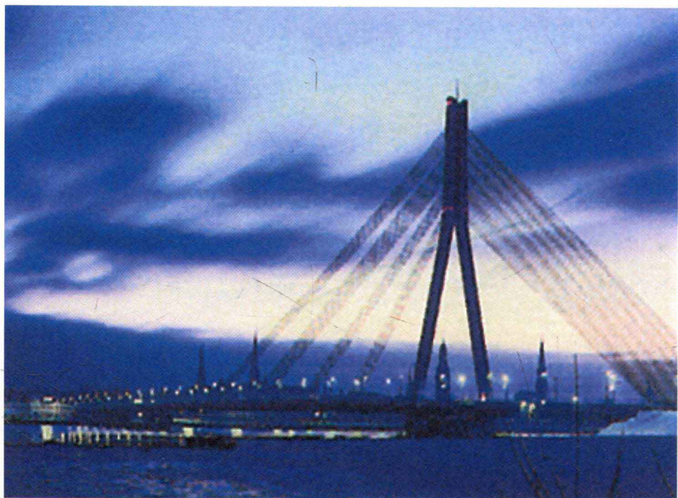
里加道加瓦河斜拉桥
