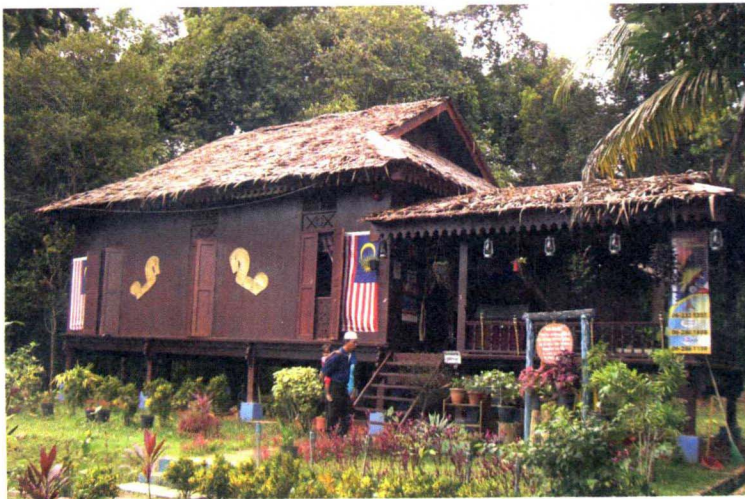
传统建筑高脚屋
