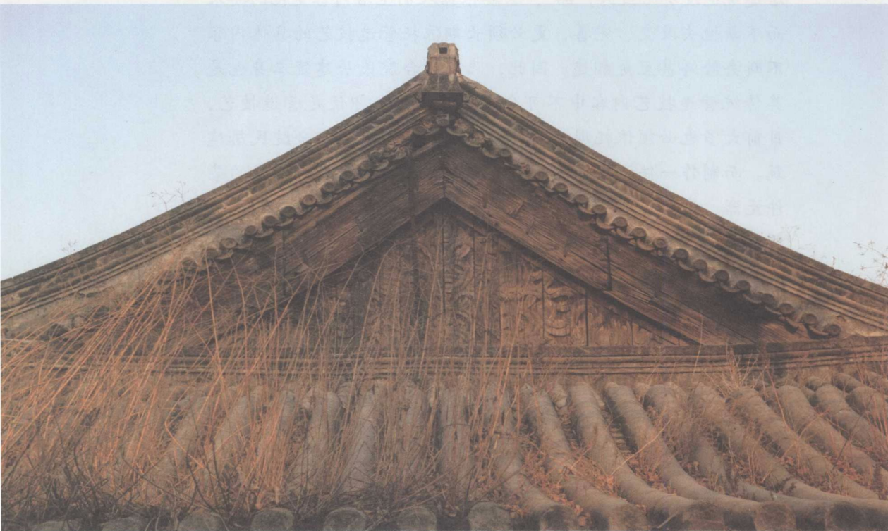
图4 北京胡同内某寺大殿屋面山面
