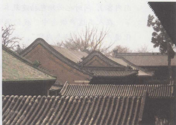
图3 北京蒙王府筒瓦与板瓦混合屋面
