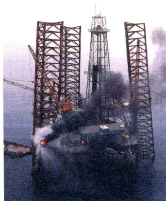
安哥拉近海石油勘探基地
