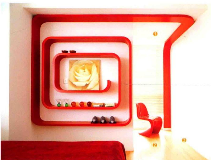
电视背景墙面用水泥砂浆找平，用木工板做出墙面上的造型，贴装饰面板，刷红色油漆。剩余墙面满刮腻子，用砂纸打磨光滑，刷底漆、面漆。最后安装踢脚线。
