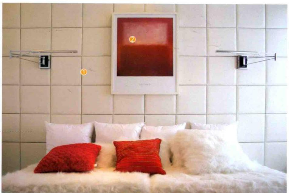
床头背景墙面用水泥砂浆找平，整个墙面用木工板打底，用气钉及万能胶将定制的软包分块固定在底板上。
