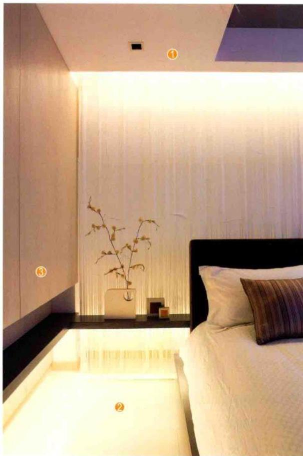
用木工板做出床头背景墙面上的层板造型，贴装饰面板后刷油漆。剩余墙面满刮三遍腻子，用砂纸打磨光滑，刷底漆、面漆，安装踢脚线，最后固定垂帘。
