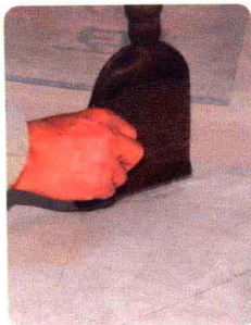
图 3-10 礅刷的使用（礅平折皱、折印）
