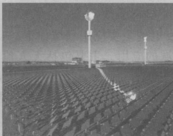
大型光伏电站
