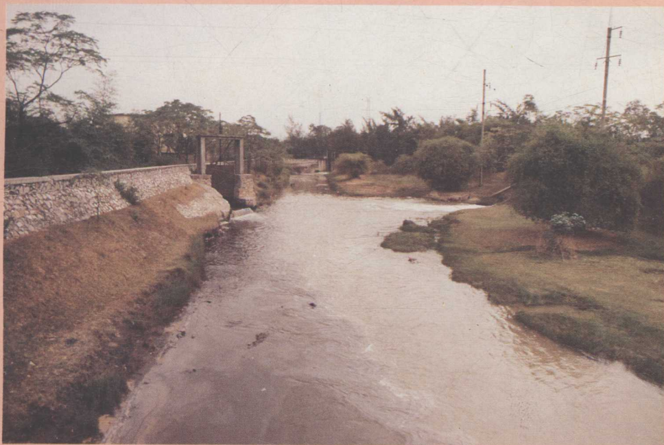
六、郁芬村附近的油公司废水、电厂废水、文冲口化工区 废水汇合处
