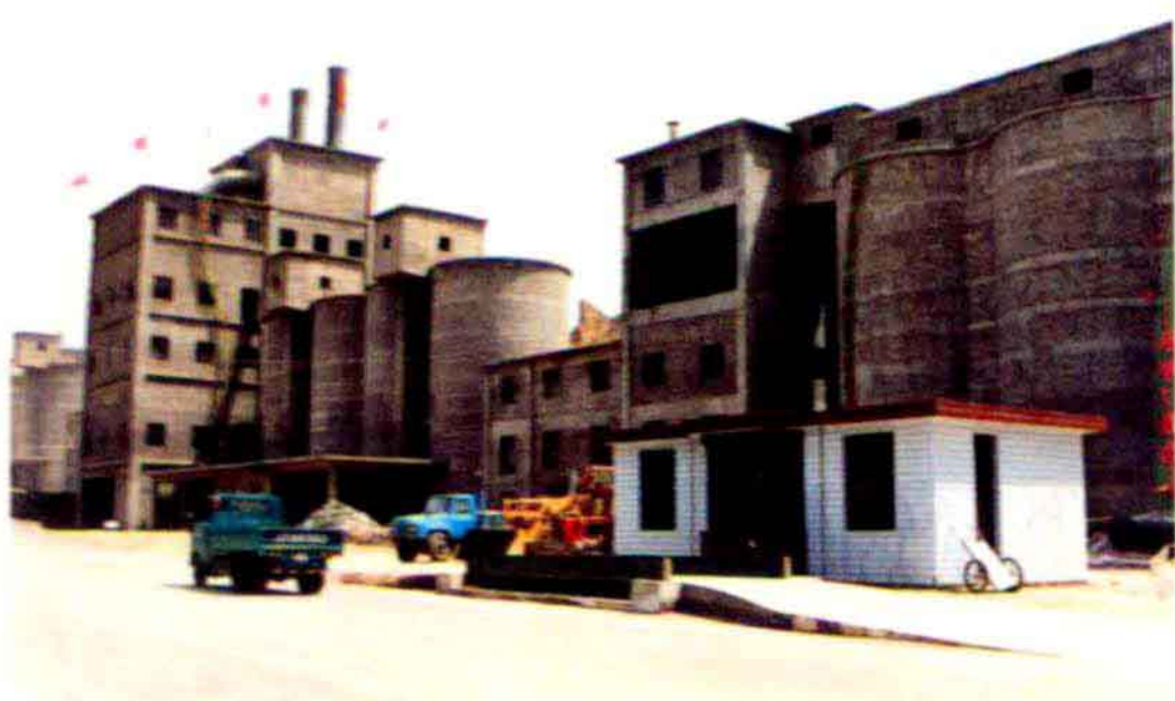
年产水泥6万吨的大寨中策水泥有限公司 Dazhai-Zhongce Cement Co. Ltd. with an annual capacity of 60,000 tons.
