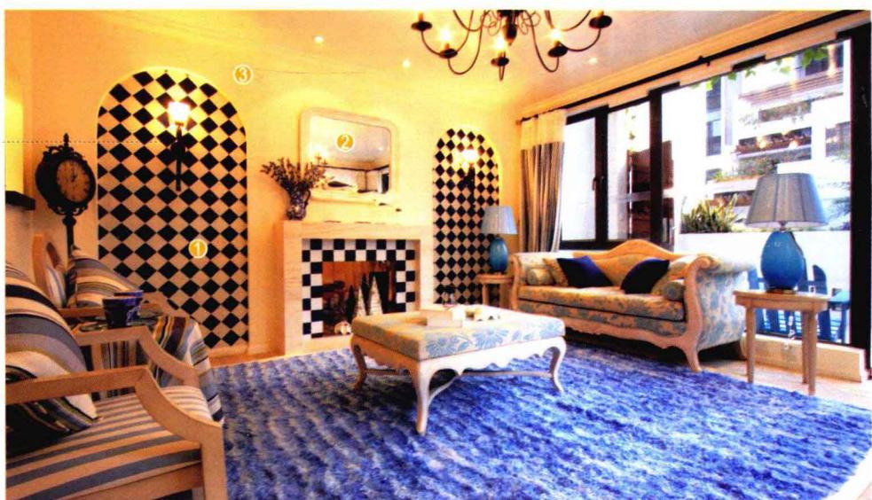
用湿贴的方式将仿古砖固定在墙面上。用AB胶将石材固定在电视背景矮台上。银镜基层用木工板打底，用粘贴固定的方式将其固定在底板上，剩余墙面满刮腻子，用砂纸打磨光滑，刷底漆、面漆，最后安装踢脚线。
