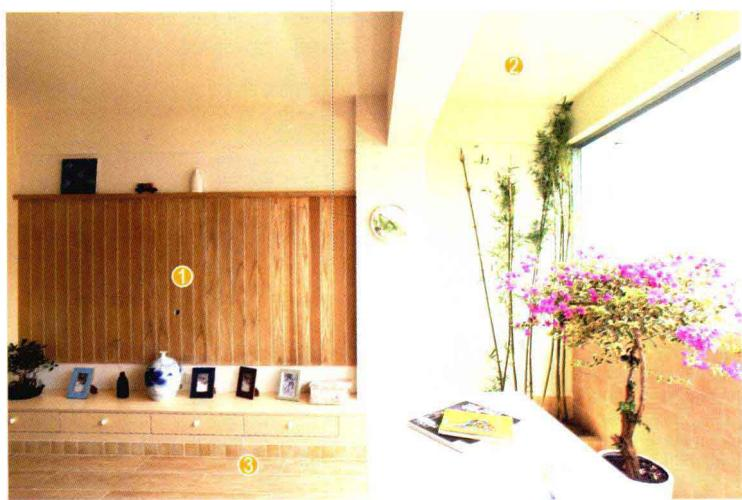
用木工板及硅酸钙板做出凹凸造型。墙面满刮腻子，用砂纸打磨光滑，刷底漆，再刷白色及有色面漆。部分墙面刷一层基膜后贴壁纸。用粘贴固定的方式将镜面固定在干净的底板上。
