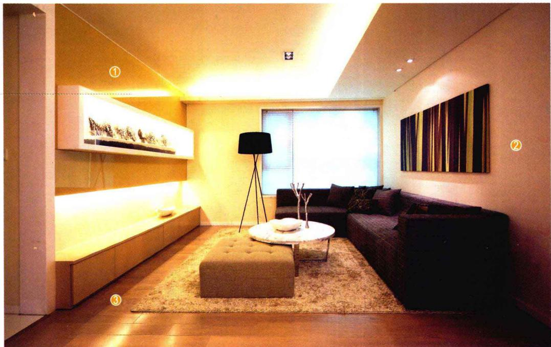
电视背景墙面用水泥砂浆找平，用木工板做出设计图中造型，部分墙面贴装饰面板后刷油漆。将定制的亚克力板固定在底板上。剩余墙面满刮腻子，用砂纸打磨光滑，刷底漆、面漆。
