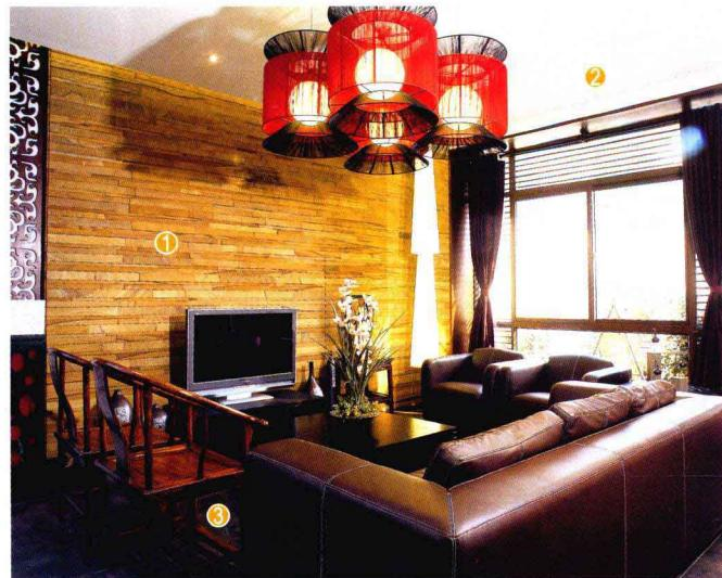
电视背景墙面用水泥砂浆找平，用湿贴的方式将文化石固定在墙面上，完工后固定收边线条。剩余墙面用水泥砂浆找平，满刮三遍腻子，刷底漆、面漆，安装成品通花板。
