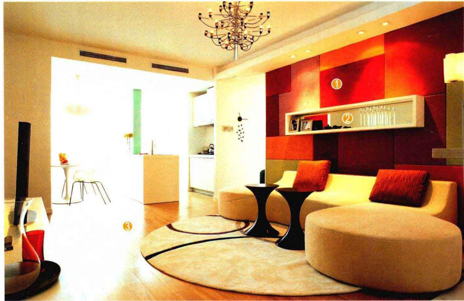
在沙发背景墙面上弹线放样，墙面用木工板打底并做出造型，层架贴装饰面板后刷油漆，用气钉及胶水将定制的软包固定在墙面上。用粘贴固定的方式将银镜固定在层板底层。
