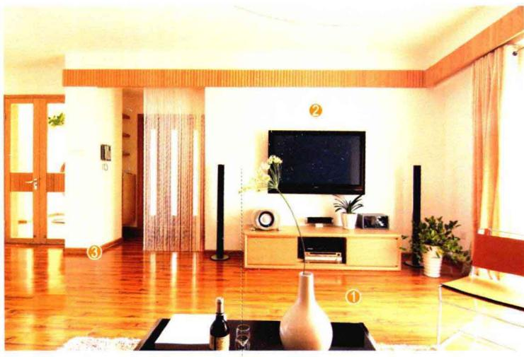
电视背景墙面用水泥砂浆找平，用木工板做出顶部装饰，贴装饰面板后刷油漆。剩余墙面满刮腻子，用砂纸打磨光滑，刷底漆、面漆。最后安装踢脚线。
