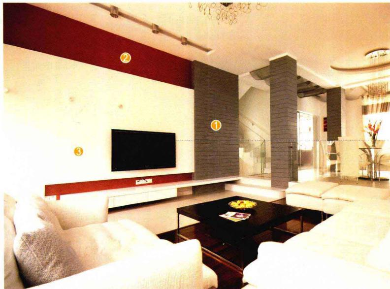
用湿贴的方式将仿古砖固定在墙面上，完工后用勾缝剂填缝。剩余墙面用硅酸钙板及木工板做出设计图中造型，电视柜贴装饰面板后刷油漆。剩余墙面满刮腻子，用砂纸打磨光滑，刷底漆，再刷白色及有色面漆。
