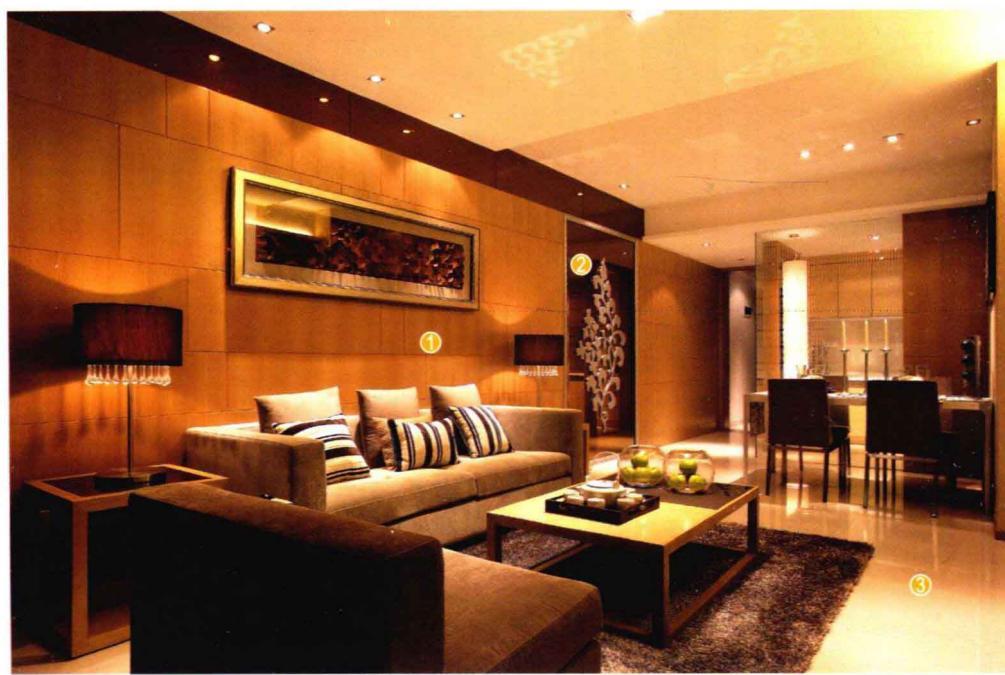
沙发背景墙面用水泥砂浆找平并作防潮处理，用木工板打底，按照设计图纸，用橡木饰面板贴面后刷油漆；贴镜面的基层清洁干净，用粘贴固定的方式将金镜固定在底板上。
