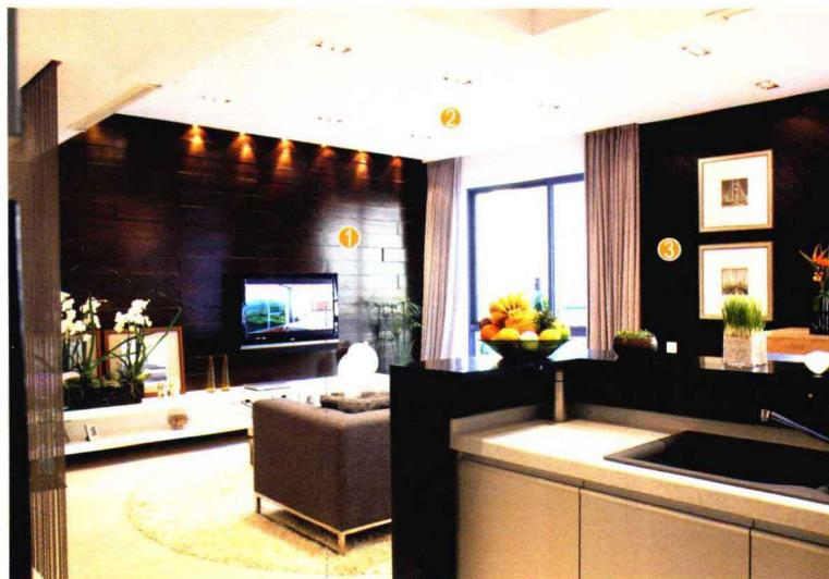
电视背景墙面用水泥砂浆找平，将复合实木地板用木板钉及胶水固定在墙面上，最后用收口条收边。
