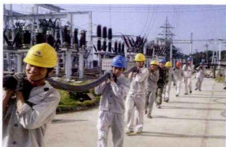
▲ 110kV那大站综合自动化改造电缆搬运
