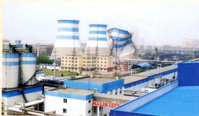
沈阳热电厂一期冷却塔拆除，标志着华电公司顺利完成“十一五”期间国家发改委制定的节能减排目标
