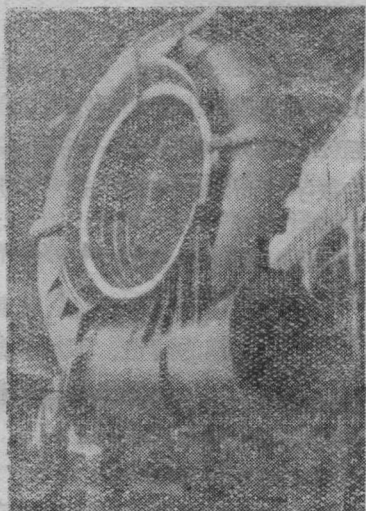
图3 谷桑惠水电站水輪机的銲接結構
