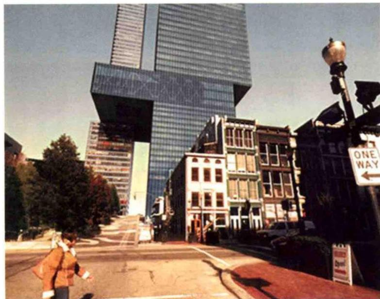
在路易维尔的博物馆广场大厦中，改变了常规高层自下而上的功能组织方式，采用“镜像”的方式将两栋高层建筑反向拼在一起。将空中的公共空间作为入口，用高速电梯将人流导向空中，分别从上下两个方向进入其他功能部分，使公共入口具有醒目的标志性，为现代城市提供了一种大尺度和高密度的功能联系模式。
