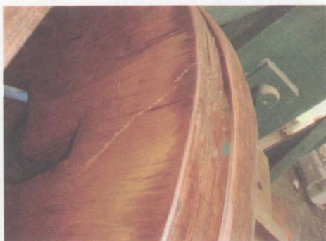
图 1-2 绕组上部层压木板贯穿性裂纹
