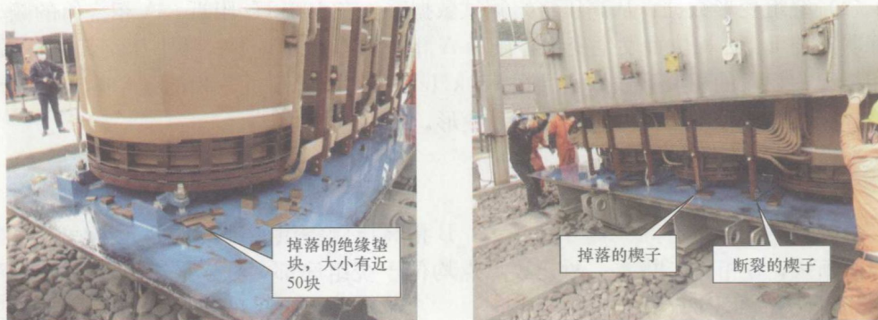
图 1-1 #2 主变压器吊罩情况
