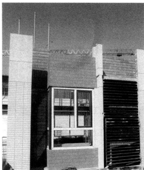
图 1-1 砌筑样板
