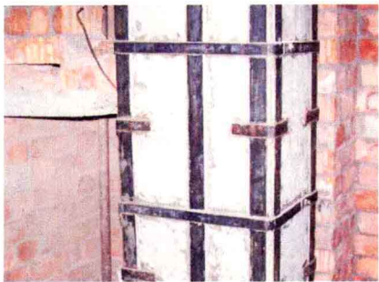
图1-49 加固立柱结构
