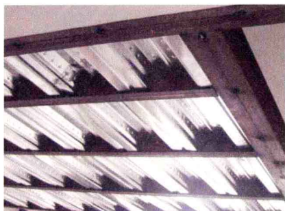
图1-31 钢结构顶棚
