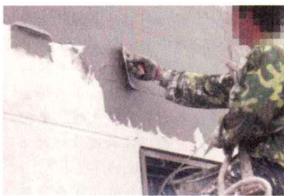
图1-35 外墙抹灰施工
