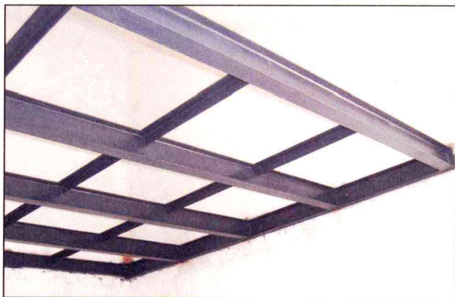
图1-38 型钢结构焊接楼板
