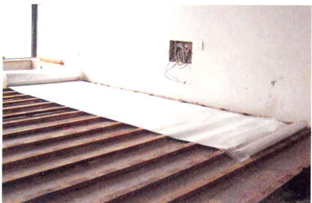
图1-39 木地板龙骨上铺装防潮毡
