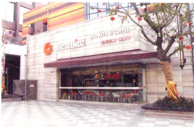
图1-17 店面外墙装修
