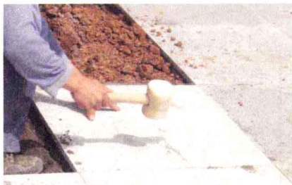
图1-34 石材铺装施工
