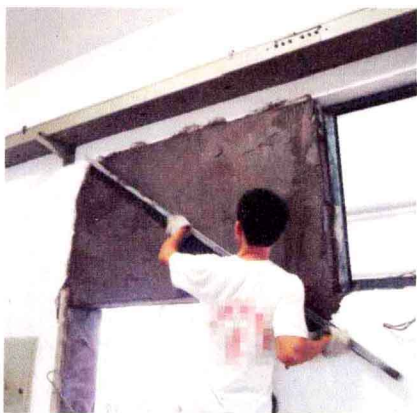
图1-40 内墙抹灰找平
