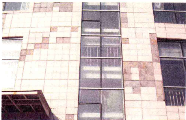
图1-27 墙面砖脱落
