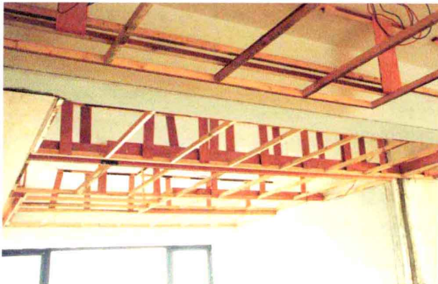
图1-47 吊顶基础构造
