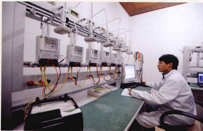
▲ 国家电能表质检中心(浙江)全力保障我省电能表产业健康发展
