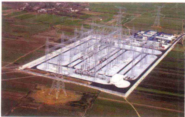
南阳 1000kV 开关站
