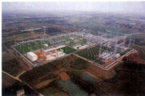
荆门 1000kV 变电站
