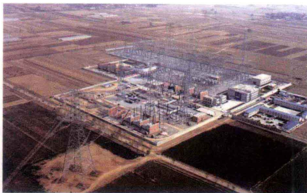
晋东南 1000kV 变电站
