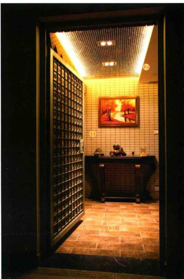
用湿贴的方式将文化石固定在墙面上，完工后用白色勾缝剂填缝，用木工板做出收边线条，贴装饰面板后刷油漆。剩余墙面满刮三遍腻子，用砂纸打磨光滑，刷底漆、面漆，最后安装实木踢脚线与装饰通花板。
