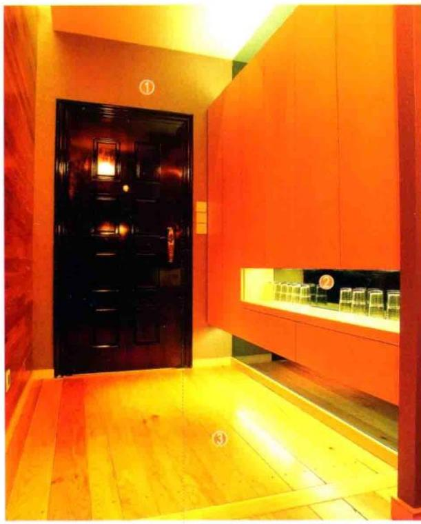
玄关墙面用水泥砂浆找平，用木工板做出储物柜造型，贴白橡木饰面板后刷油漆。镜子基层用木工板打底，用玻璃胶将银镜固定在底板上，完工后用密封胶密封，最后固定踢脚线。
