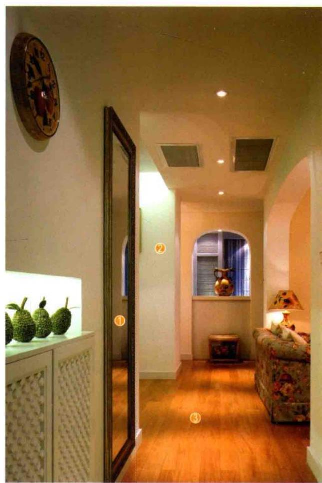
用木工板做出玄关墙面上的储物柜，贴装饰面板后刷油漆。镜面基层用木工板打底，剩余墙面满刮三遍腻子，用砂纸打磨光滑，刷底漆、面漆。用粘贴固定的方式将银镜固定在底板上，安装收边线条。
