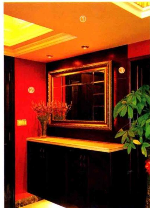
玄关墙面用水泥砂浆找平，用木工板做出鞋柜造型，贴装饰面板后刷油漆。剩余墙面满刮三遍腻子，用砂纸打磨光滑，刷一层基膜后贴壁纸。
