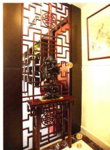
用木工板做出玄关处两侧木结构，贴装饰面板后刷油漆，最后用螺钉及万能胶固定成品通花板。
