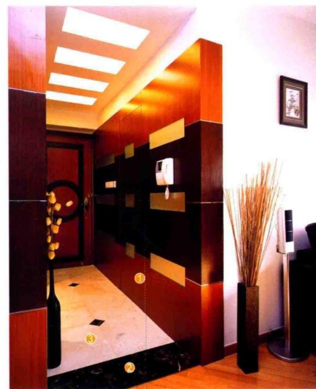
玄关墙面用木工板打底并做出隐形门结构，墙面贴柚木和铁刀木饰面板，刷油漆。剩余墙面满刮三遍腻子，用砂纸打磨光滑，刷底漆、白色及有色面漆。
