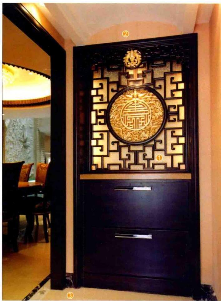
用木板做出玄关处鞋柜造型，贴装饰面板后刷油漆，剩余墙面满刮三遍腻子，用砂纸打磨光滑，刷一层基膜后贴壁纸，固定通花板。
