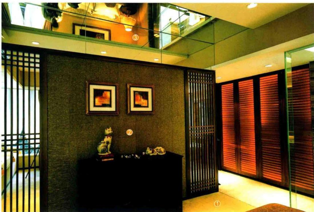
玄关墙面用水泥砂浆找平，整个墙面满刮三遍腻子，用砂纸打磨光滑，固定成品实木线条及木花格，墙面刷一层基膜，用环保白乳胶配合专业壁纸粉将壁纸固定在墙面上。
