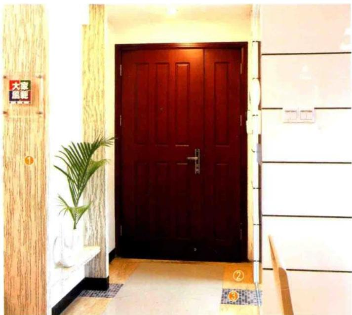
玄关墙面用水泥砂浆找平，用湿贴的方式将踢脚线固定在墙面上，用木工板做出墙面上的木结构及层板，贴斑马木饰面板后刷油漆。剩余墙面满刮三遍腻子，用砂纸打磨光滑，刷底漆、面漆。
