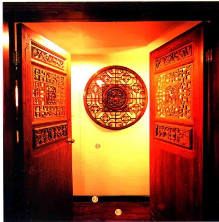
玄关端景墙面用水泥砂浆找平，整个墙面满刮三遍腻子，用砂纸打磨光滑，刷底漆、有色面漆，安装实木踢脚线，固定实木挂件。
