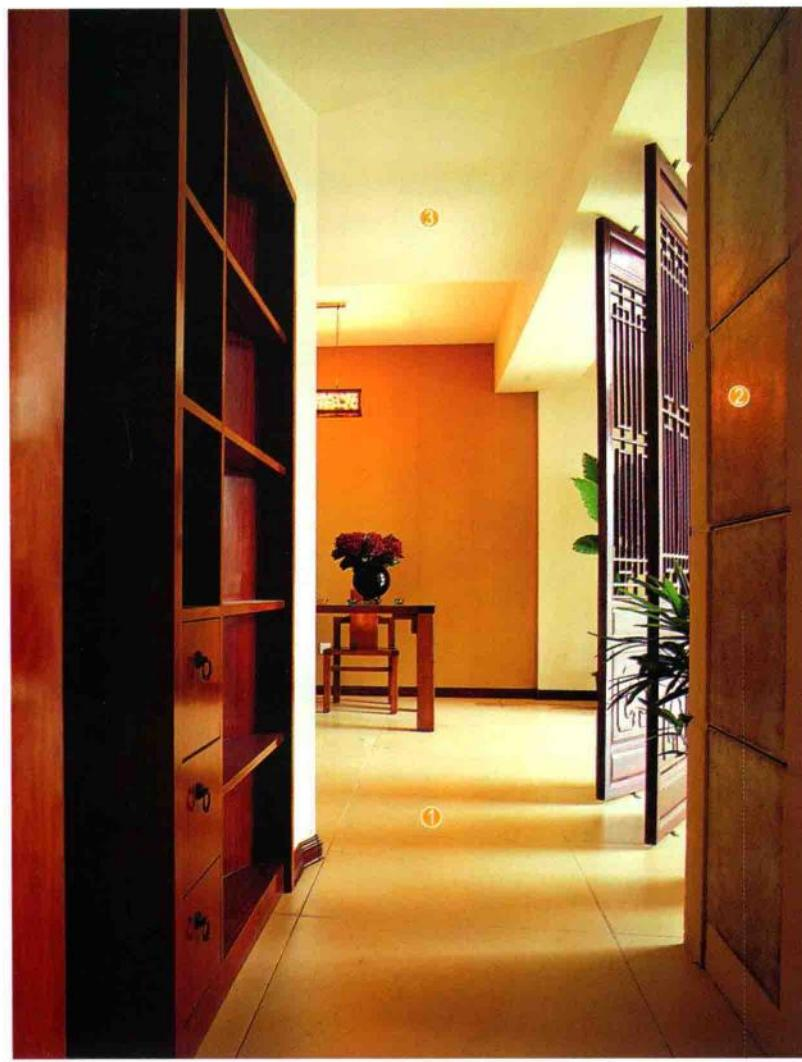
入户墙面用水泥砂浆找平，用湿贴的方式将仿古砖固定在墙面上。剩余墙面用木工板打底，用气钉及万能胶将订制的软包分块固定在底板上。
