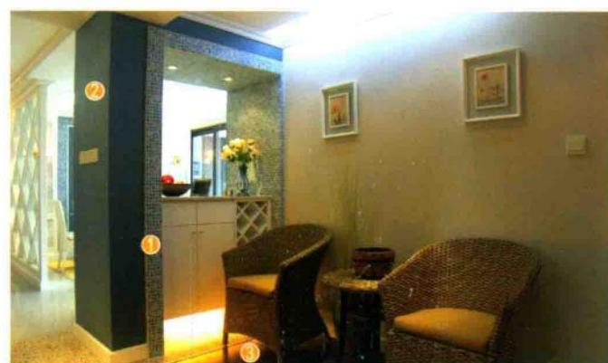
玄关墙面用水泥砂浆找平，用白水泥将马赛克固定在墙面上。用木工板做出鞋柜，贴水曲柳饰面板后刷油漆。剩余墙面满刮三遍腻子，用砂纸打磨光滑，刷底漆、有色面漆。
