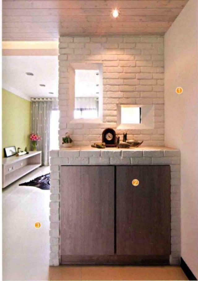
玄关墙面用木工板做出储物柜造型，贴装饰面板后刷油漆，剩余墙面满刮三遍腻子，用砂纸打磨光滑，刷底漆、面漆。
