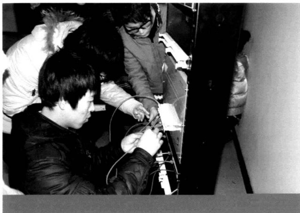
网络布线实训室
