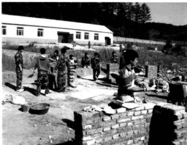
建筑工程实训基地
