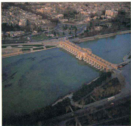
伊斯法罕哈珠大桥
