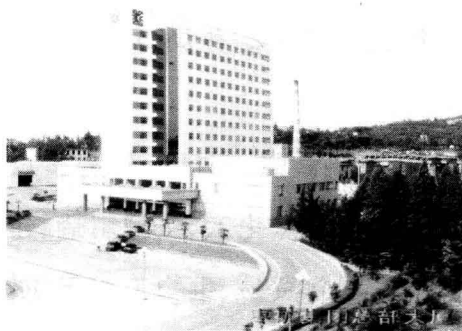
图 2 枣庄矿业集团公司总部大厦
