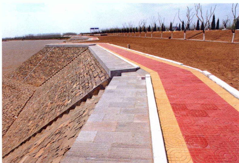
郟城杨集上延控导工程（2005年）。
