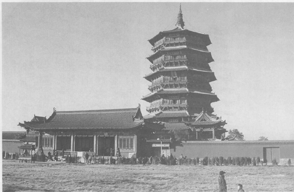
图1-5 山西应县木塔
