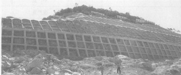
图 1.2 施工中的某高边坡
