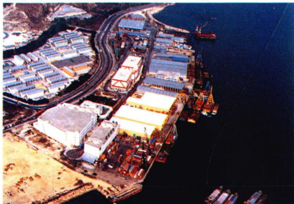
圖 35.6 屯門內河貨運碼頭是裝卸貨物的重要設施。
