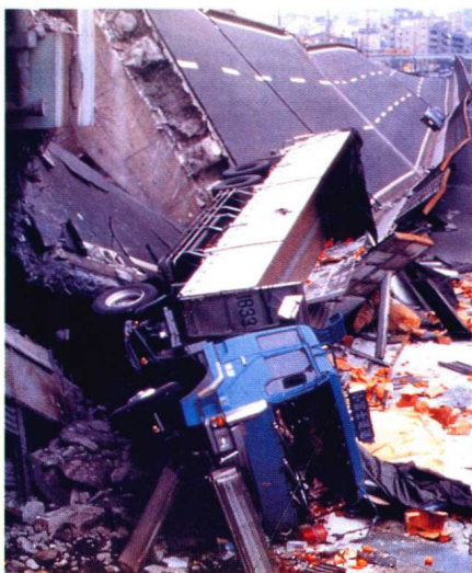
圖 35.3 地震可破壞道路運輸系統。圖為日本神戶地震的情景，道路出現裂縫，使陸路運輸癱瘓。
