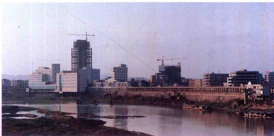
由黄华先生投资兴建的望江楼及江边路改造工程
