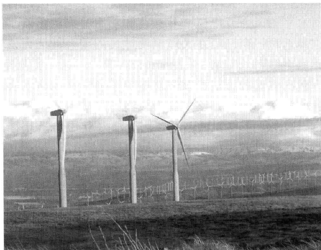
图 1-1 现代三叶片上风向水平轴风力发电机（图中风向由右向左）
