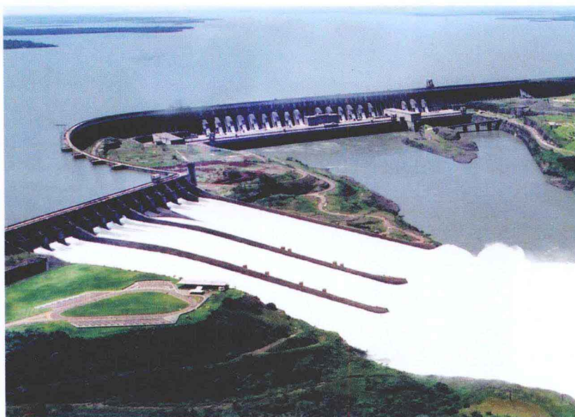
图 7-9-14 伊泰普水电站俯瞰图
