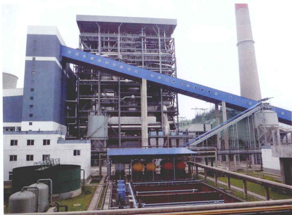
图 10-4-2 我国自主知识产权的 30 万 kW 亚临界循环流化床锅炉
