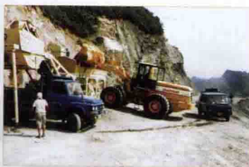
繁忙的公路建设工地
