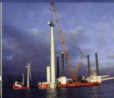
风机海上运输、安装
