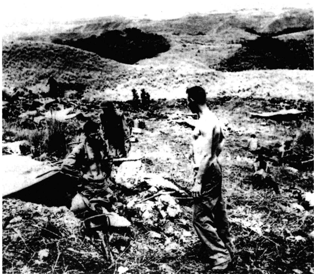
上图：美军正在瓜岛修筑防御工事。
