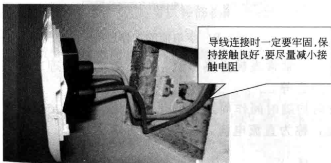
图 1-6 施工时应尽量减小接触电阻
