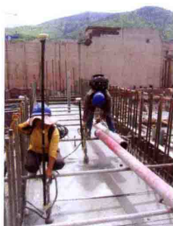
彩图 26 安装间上游段振捣
