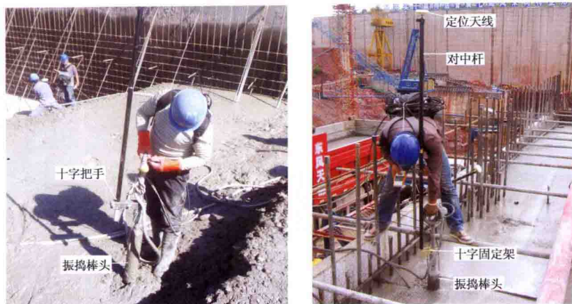
彩图 24 振捣棒端头定位天线固定
