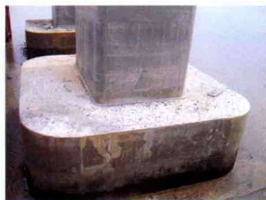
彩图 42 跨海大桥桥墩
