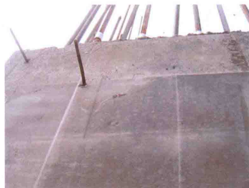
彩图 52 观音岩水电站厂房安装间上游墙
