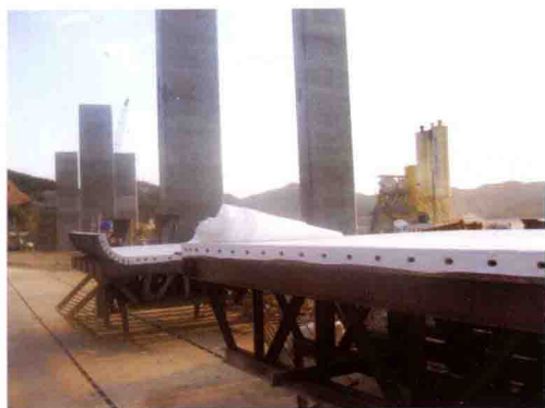
彩图 49 浙江象山港大桥桥墩
