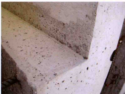
彩图 8 墩台拆模后新浇混凝土表面蜂窝
