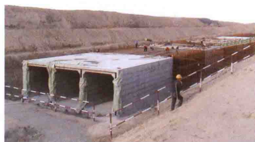
彩图 53 南水北调天津段箱涵内肋墙
