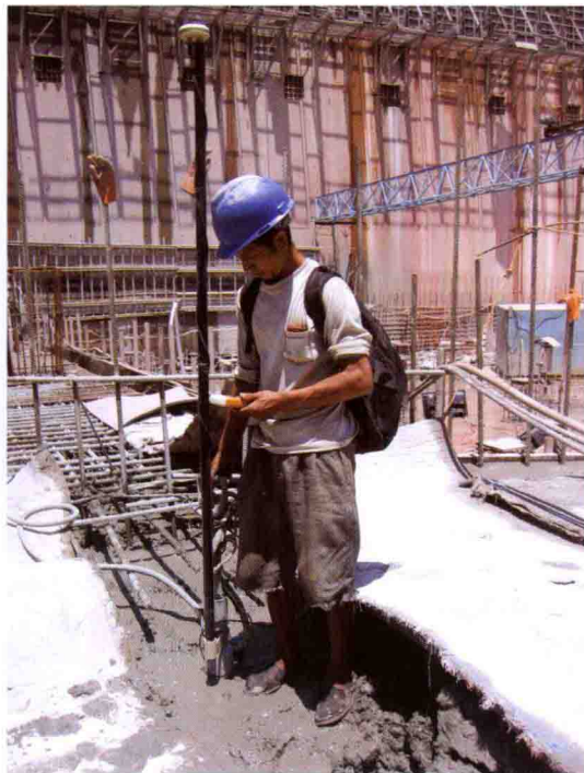
(b) 振捣现场设备装置
