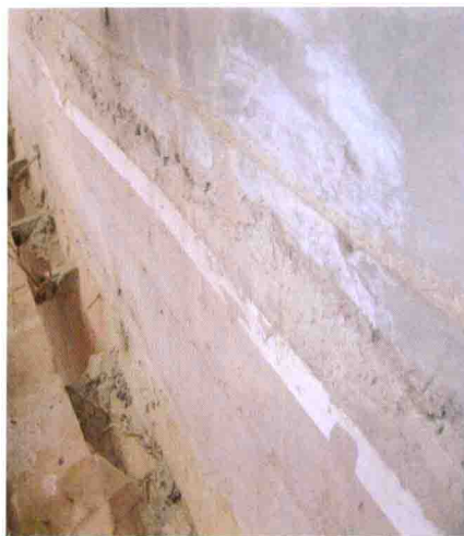
彩图 14 混凝土分层浇筑形成酥松夹层
