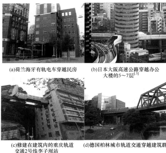
图 1.1 国内外各种城市交通近距离穿越建筑物
