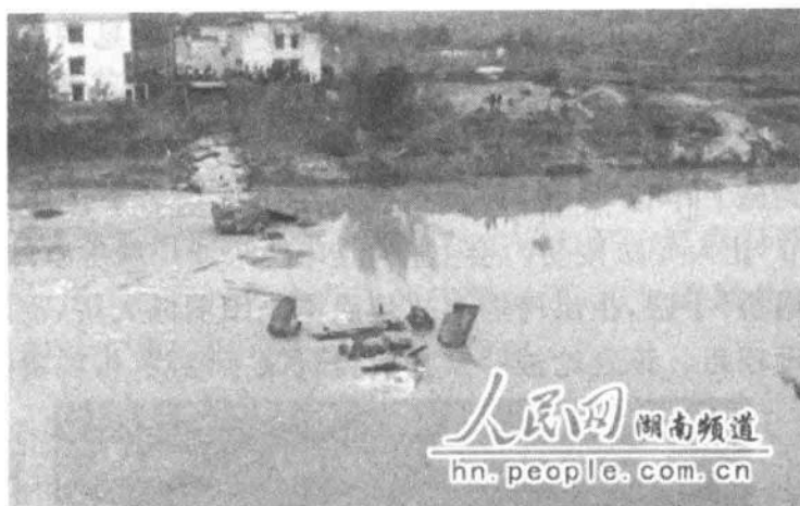
图 1-1-3 平江范固桥垮塌事件
