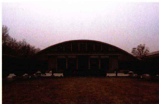
Vue extérieure de la fosse N° 1
