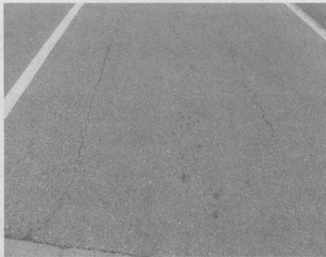
图 2.10 纵向裂缝
