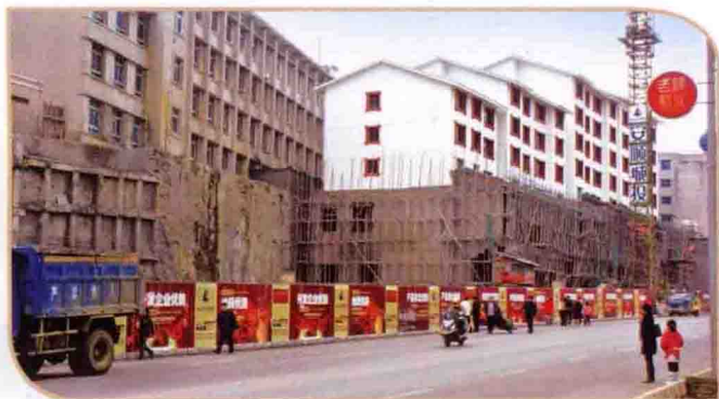
友爱路拆迁安置工程1#楼
