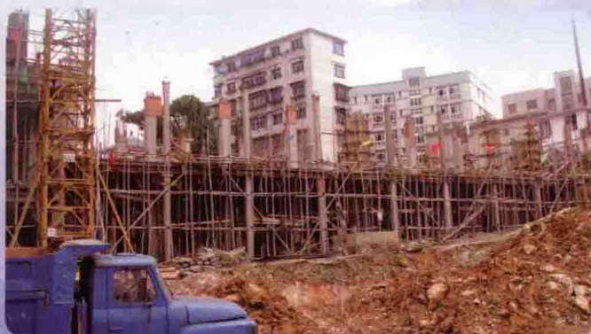
友爱路拆迁安置工程1#楼建设工地
