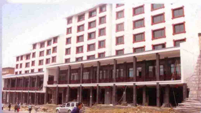
已竣工的友爱路拆迁安置工程1#楼
