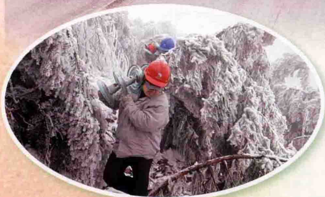
安供抢修队员搬运110kV中纳线抢修物资
