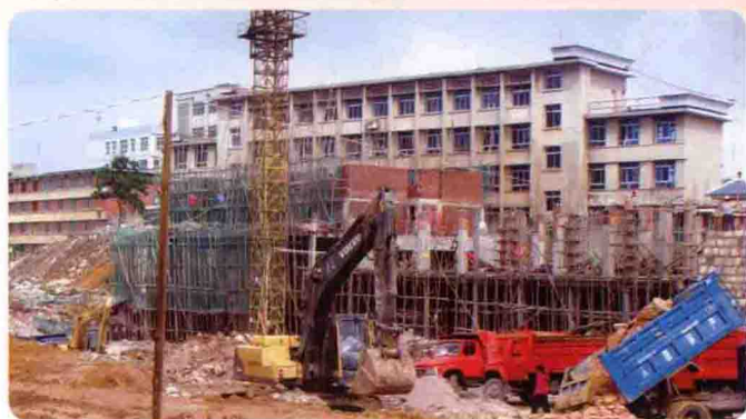
建设中的友爱路拆迁安置工程1#楼
