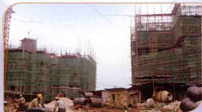
龙泉路住宅小区工程建设工地
