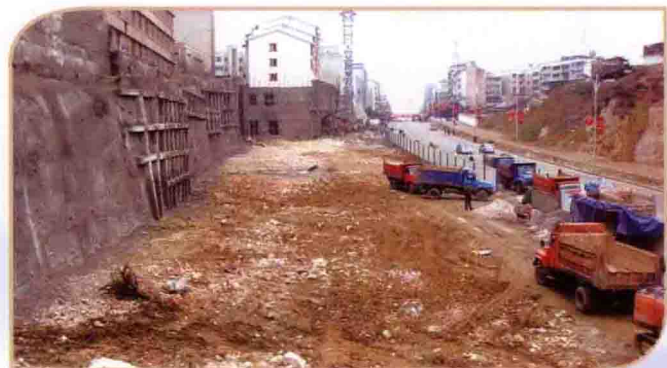
友爱路拆迁安置工程3#楼建设工地
