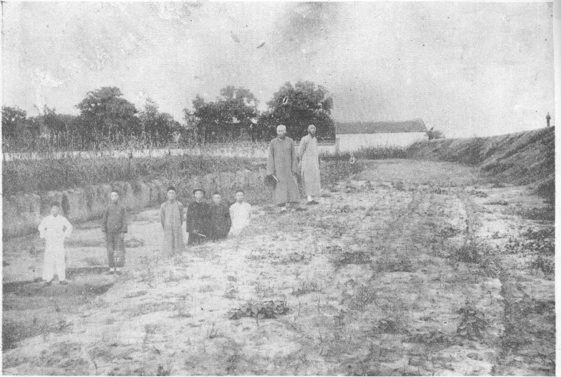
修築福音堂西首土堤竣工
