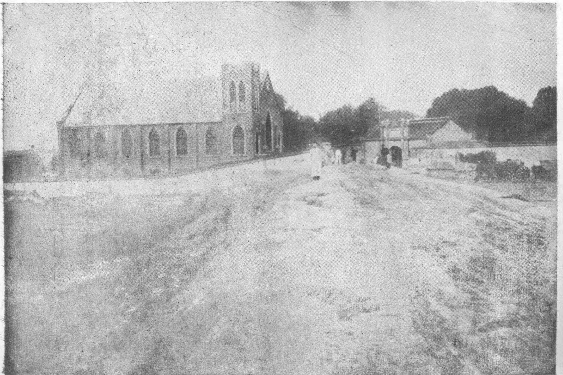
修築福音堂東首土堤竣工
