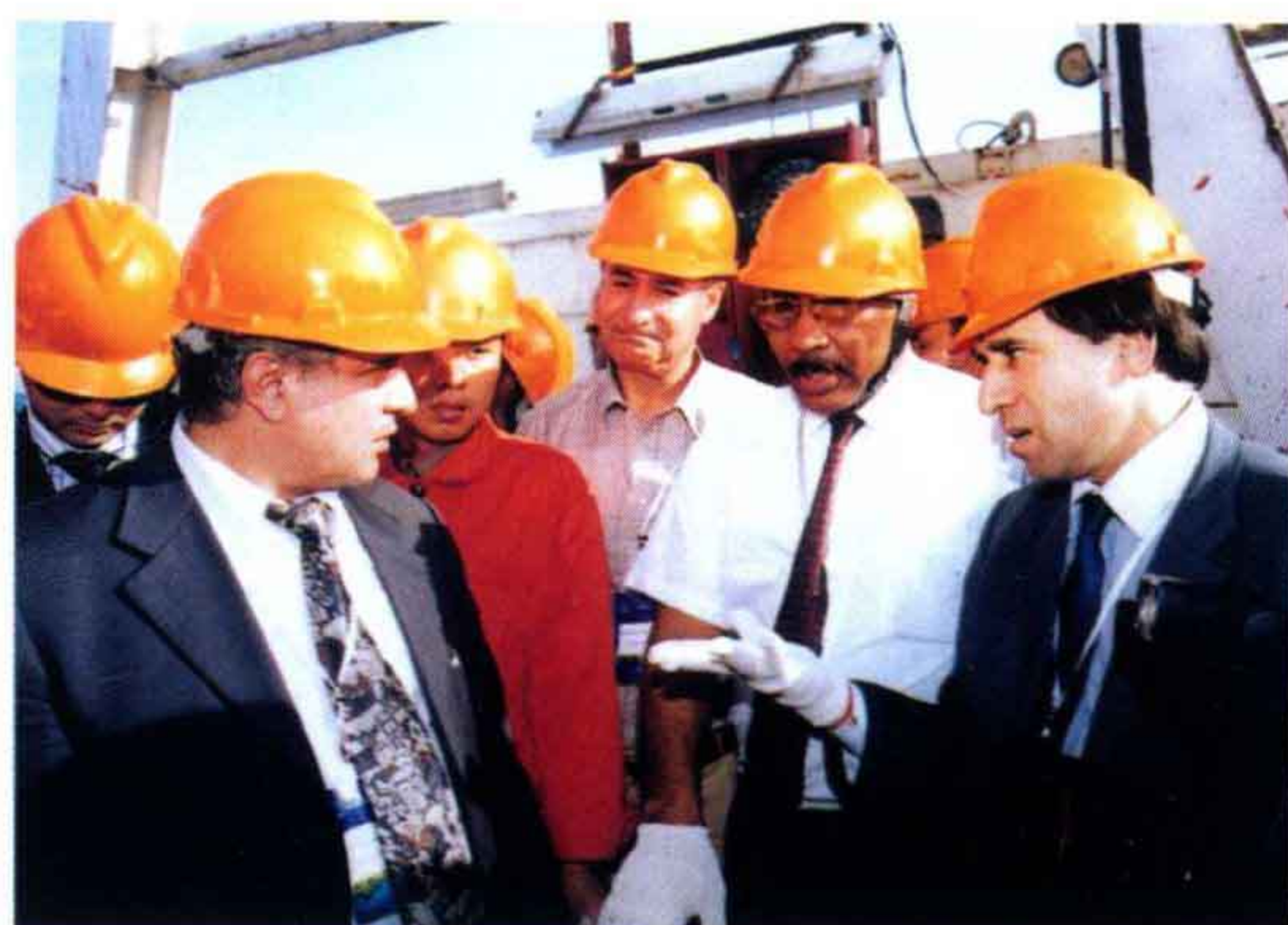
国外石油专家在施工现场> (摄影：王英春)
