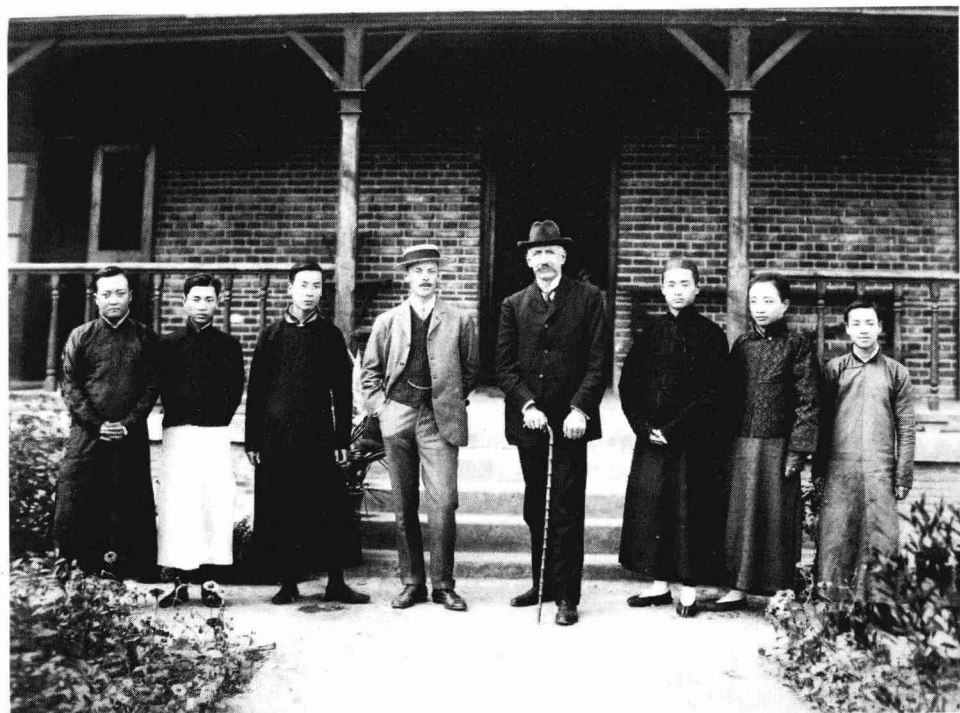
修建津浦铁路的工程技术人员
